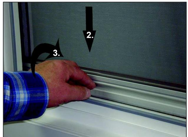
**!** Beim Entriegeln des Insektenschutzes ohne Bremse ist zu beachten, dass die Gaze so weit wie möglich nach oben geführt wird um Beschädigungen durch zu schnelles oder ruckartiges Einfahren zu verhindern.
